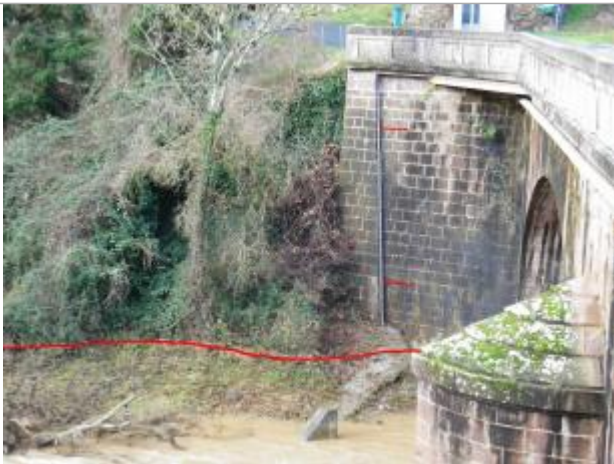
Le repère de 1930 est au niveau de la flèche rouge du bas
