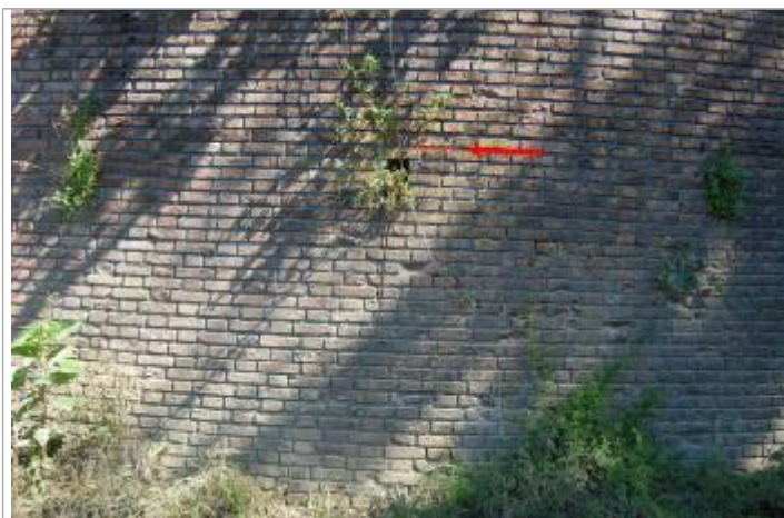
Vue du repère - Géosphair
