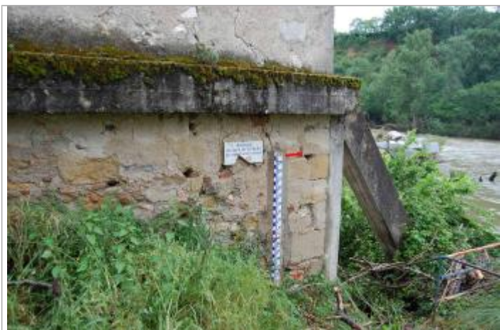
Vue du repère - Géosphair
