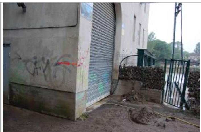
Vue du repère - Géosphair
