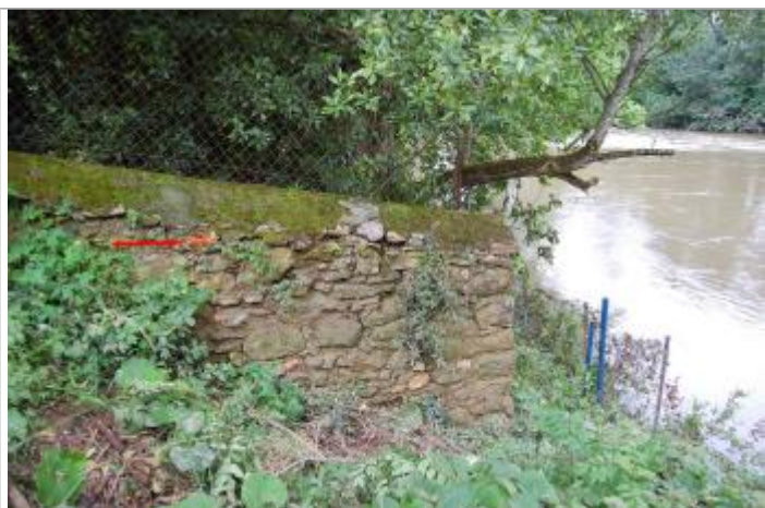
Vue du repère - Géosphair
