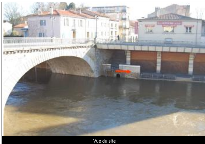
Vue du site
