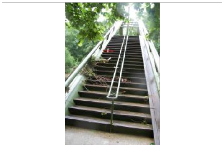
Vue du repère - Géosphair
