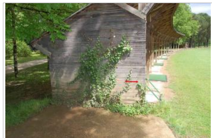
Vue du repère - Géosphair
