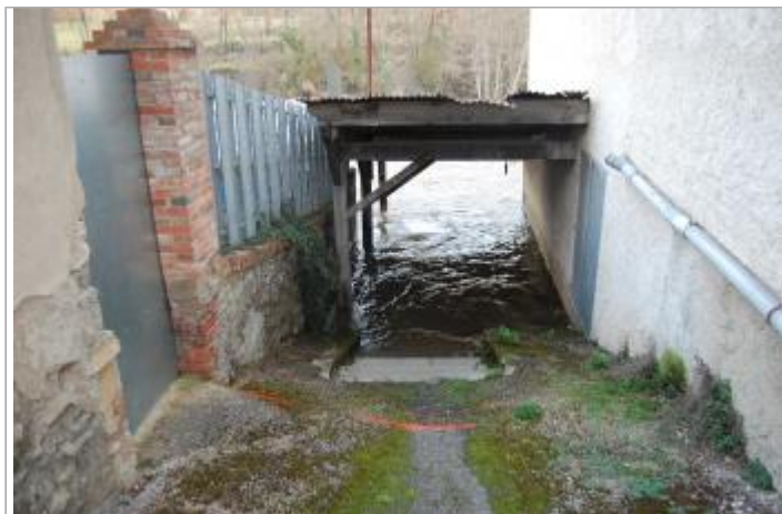
Vue du site
