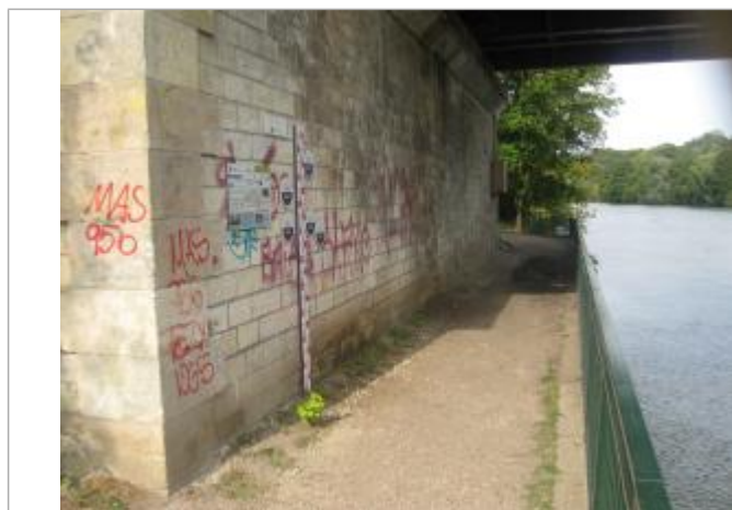
Photo des repères
