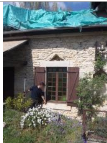
Site et repère de la crue de 1977
