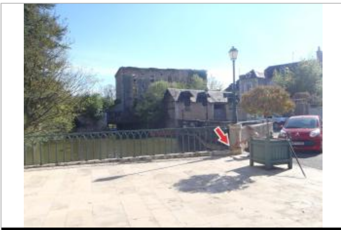
Site et repère de la crue de 1940
