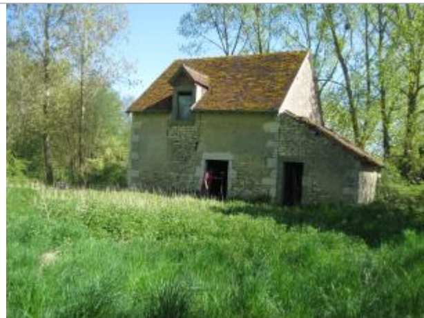
Site et repère de la crue de 1977
