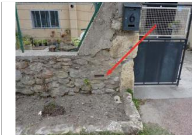
Vue du site
