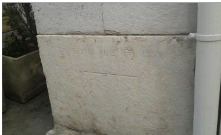
Photo du repère - Auteur : SPC_ADN
