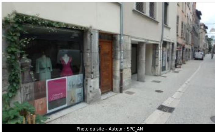
Photo du site - Auteur : SPC_AN
