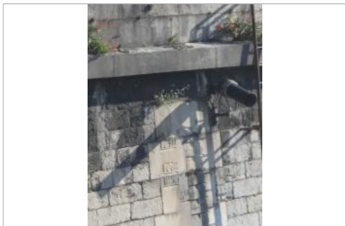
Photo du repère - Auteur : SPC_ADN
