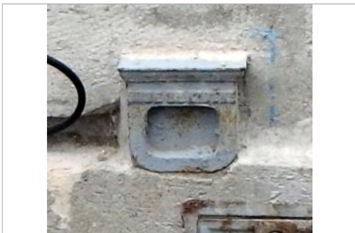
Photo du repère - Auteur : SPC_ADN
