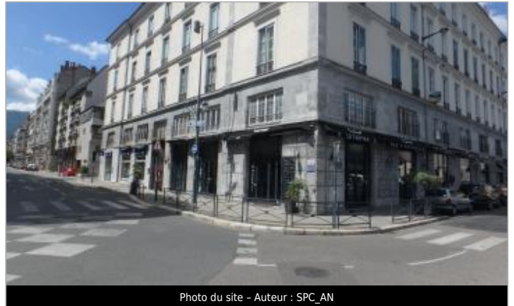
Photo du site - Auteur : SPC_AN
