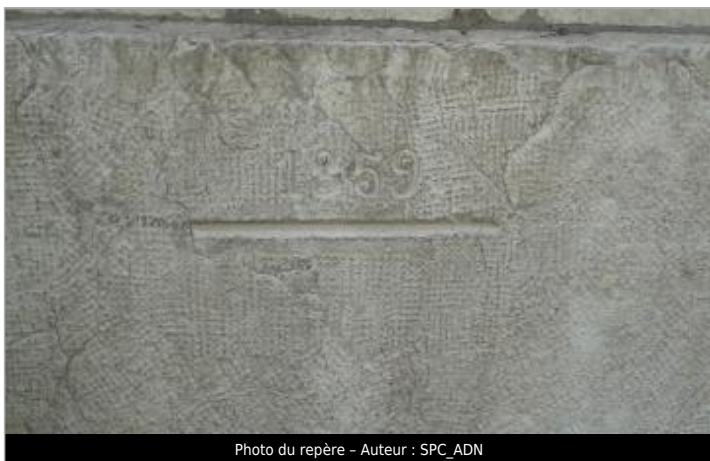
Photo du repère - Auteur : SPC_ADN
