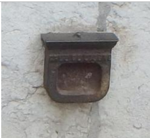
Photo du repère - Auteur : SPC_ADN
