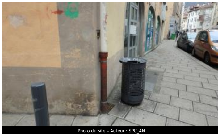
Photo du site - Auteur : SPC_AN
