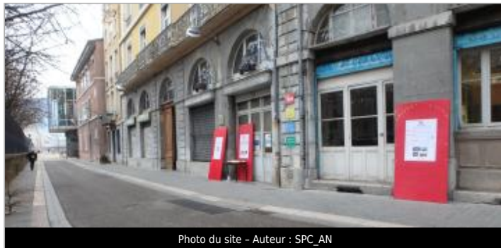
Photo du site - Auteur : SPC_AN
