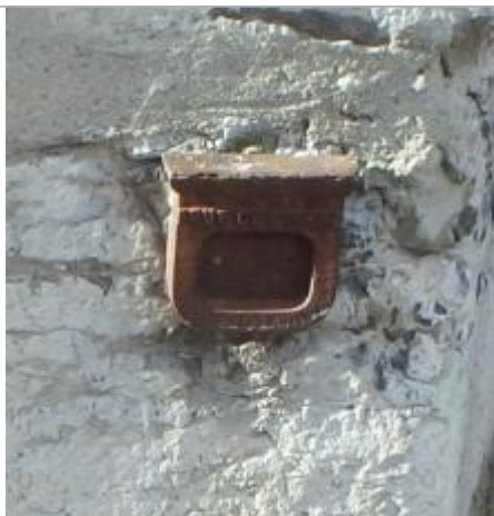
Photo du repère - Auteur : SPC_ADN
