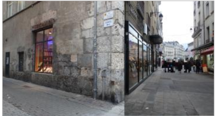
Photo du site - Auteur : SPC_AN
