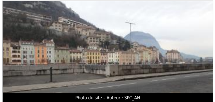
Photo du site - Auteur : SPC_AN
