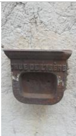
Photo du repère - Auteur : SPC_ADN
