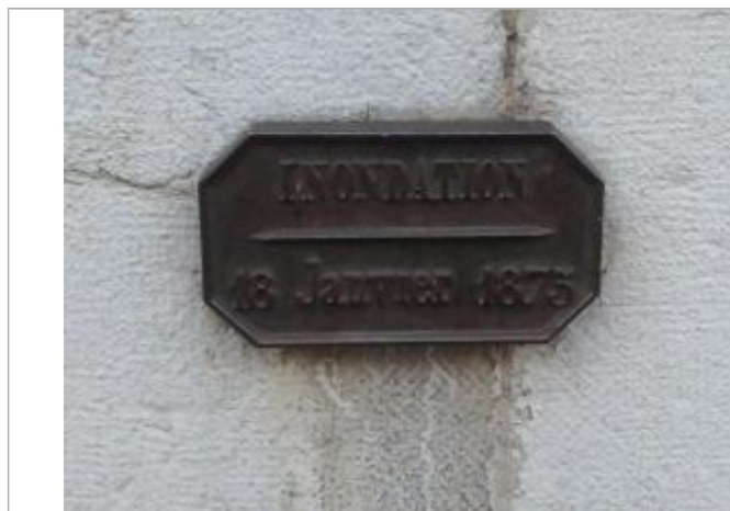
Photo du repère - Auteur : SPC AN
