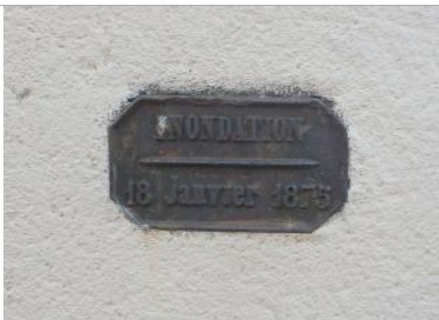
Photo du repère - Auteur : SPC AN
