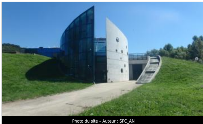
Photo du site - Auteur : SPC_AN
