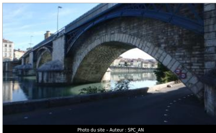
Photo du site - Auteur : SPC_AN
