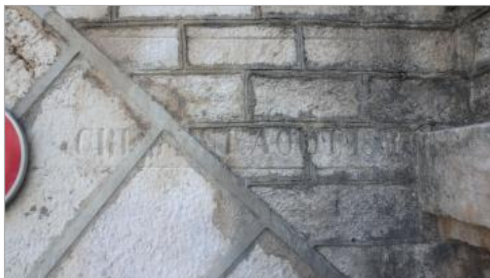
Photo du repère - Auteur : SPC_ADN
