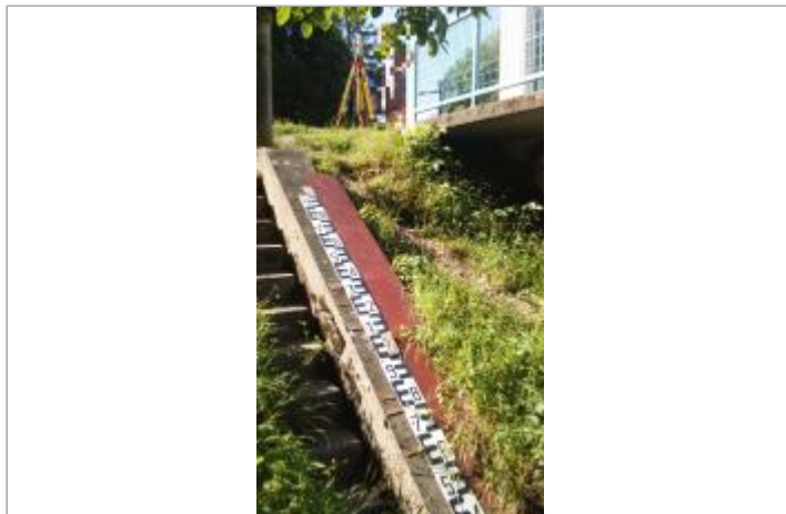
Photo du site - Auteur : SPC_AN
