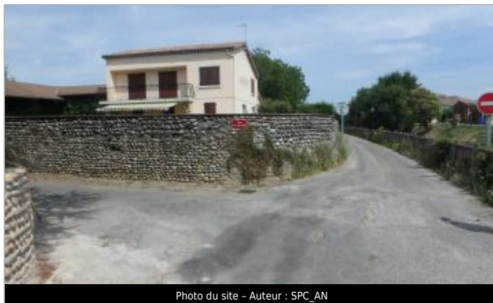
Photo du site - Auteur : SPC_AN
