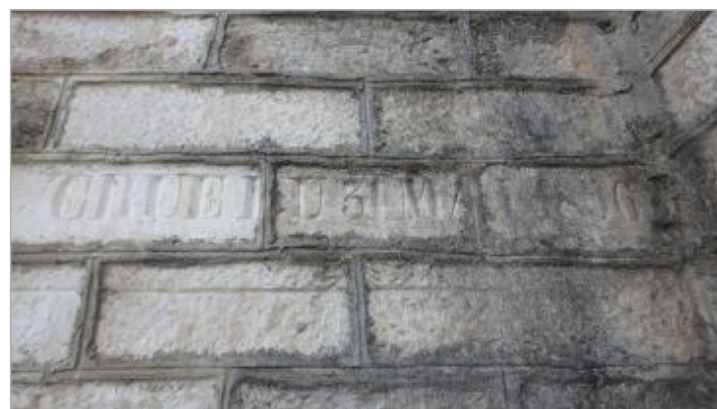
Photo du repère - Auteur : SPC_ADN
