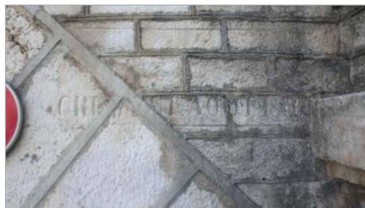
Photo du repère - Auteur : SPC_ADN
