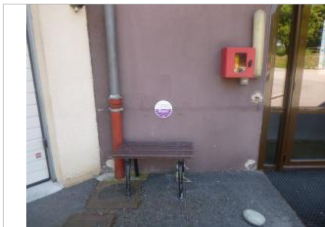
Laisse de crue
