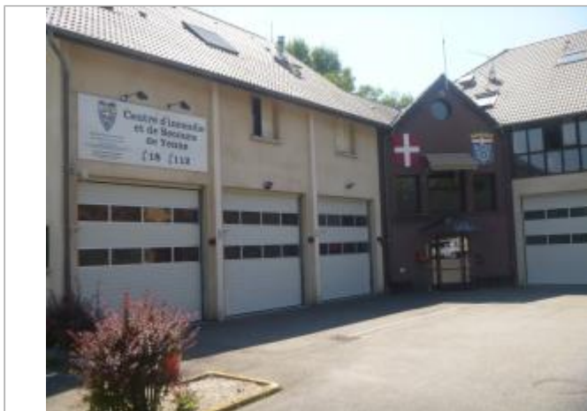
caserne des pompiers
