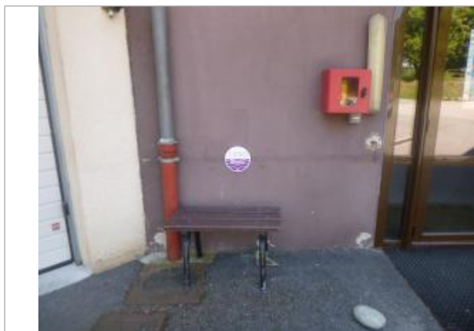
Laisse de crue
