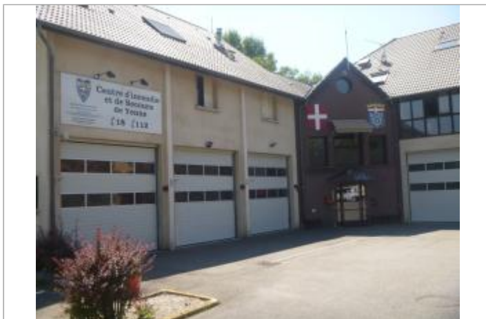
caserne des pompiers
