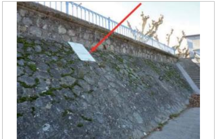
Vue du site
