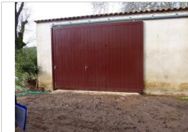
Photo du site - Auteur : Cerema DTer Méditerranée
