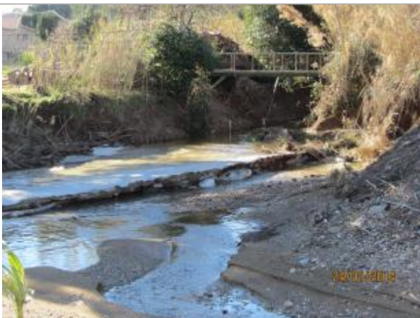
Photo PHE - Auteur : Cerema DTer Méditerranée
