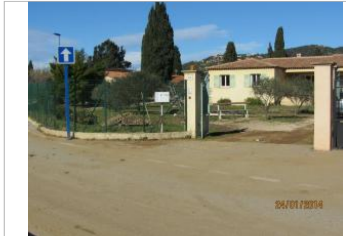
Photo du site - Auteur : Cerema DTer Méditerranée
