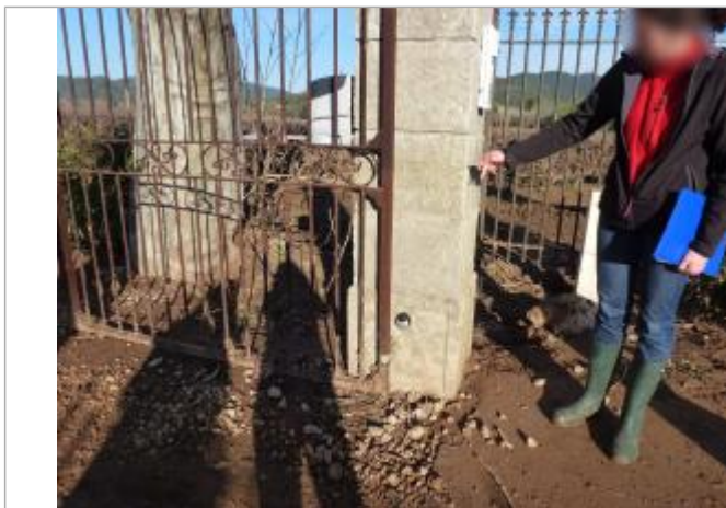
Photo PHE - Auteur : Cerema DTer Méditerranée
