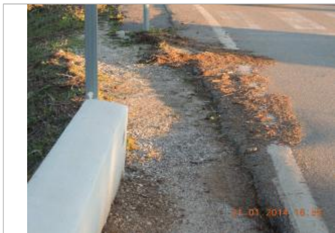
Photo PHE - Auteur : Cerema DTer Méditerranée
