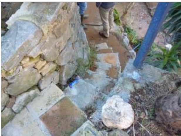
Photo PHE - Auteur : Cerema DTer Méditerranée
