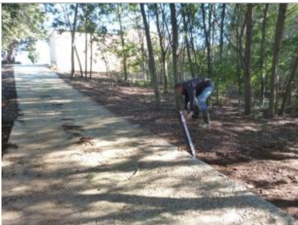
Photo PHE - Auteur : Cerema DTer Méditerranée
