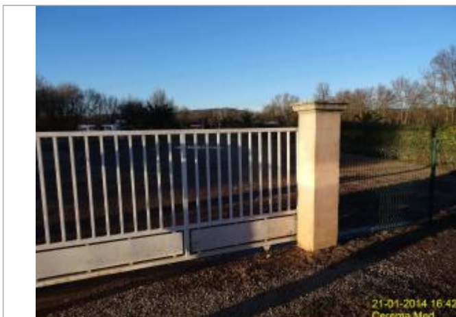
Photo PHE - Auteur : Cerema DTer Méditerranée
