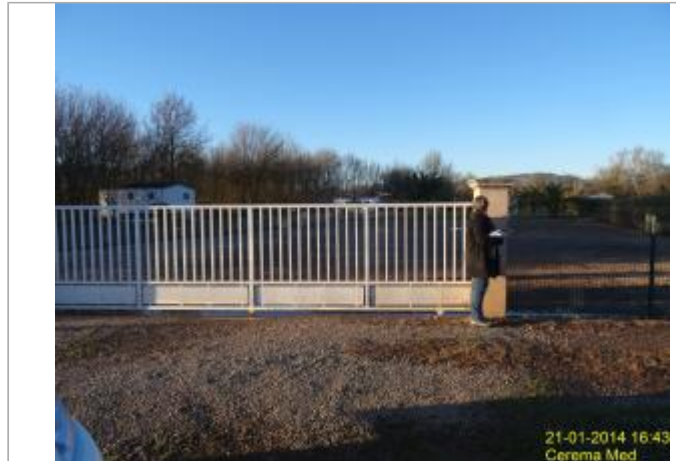
Photo du site - Auteur : Cerema DTer Méditerranée
