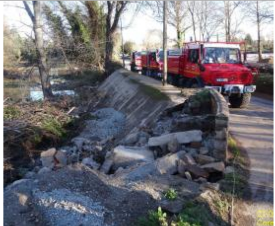
Photo du site - Auteur : Cerema DTer Méditerranée
