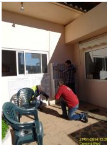
Photo PHE - Auteur : Cerema DTer Méditerranée
