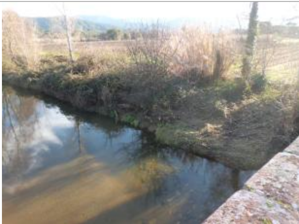
Photo PHE - Auteur : SAFEGE
