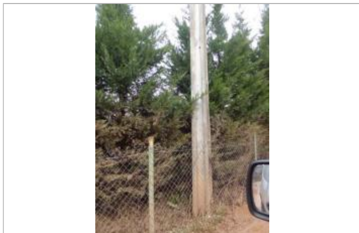
Photo PHE - Auteur : SAFEGE
