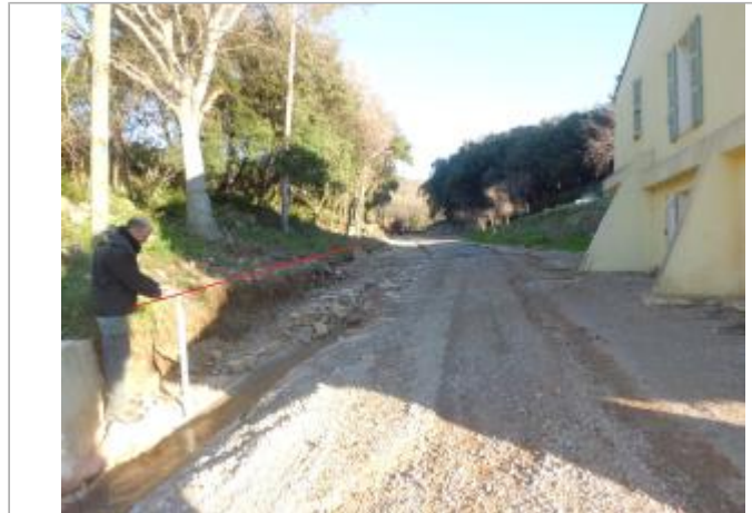
Photo du site - Auteur : SAFEGE
