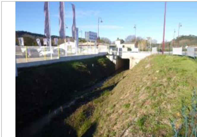
Photo du site - Auteur : SAFEGE
