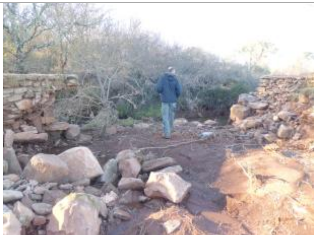
Photo PHE - Auteur : SAFEGE
